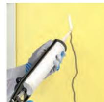
**INTOFISS** è un sigillante acrilico effetto intonaco. Aderisce ottimamente su tutti i materiali porosi, anche se temporaneamente umidi. Di facile lavorabilità, verniciabile dopo 30 minuti dall'applicazione.
