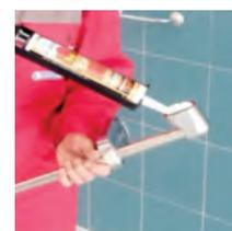
**SUPERFISS** è un adesivo monocomponente forte, di alta qualità, con una presa molto resistente a base di nuovi polimeri. Questa è la ragione per cui non è necessario il supporto dell'assemblaggio dell'adesivo in generale. Il prodotto è inodore, neutro, senza silicene e isocianati. Dopo l'applicazione SUPERFISS polimerizza con l'umidità dell'atmosfera per formare un sigillante durevole.
