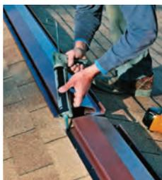
KEBIFLEX ha un'ottima adesione sulla maggior parte di materiali edili (cemento, legno, lamiera, alluminio, ecc.), anche su superfici umide. Ideale per fissare scossaline, sigillare grondaie, pluviali, camini e perdite sul tetto. È particolarmente indicato per l'incollaggio e la sigillatura di membrane bituminose e la posa di tegole e pannelli isolanti (escluso polistirolo espanso).
